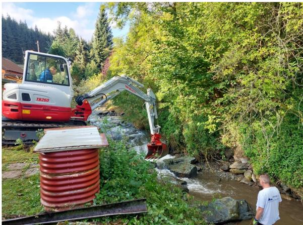
Nach dem Starkregen vom September 2023 waren einige Bachsanierungen notwendig. Im Bereich von Haus Nr. 164, (Talergraben) beim Ottenbach und im Bereich Haus Nr. 72 waren einige Steine im Böschungsbereich lockergerissen und mussten gesichert, bzw. neu eingebaut werden.
