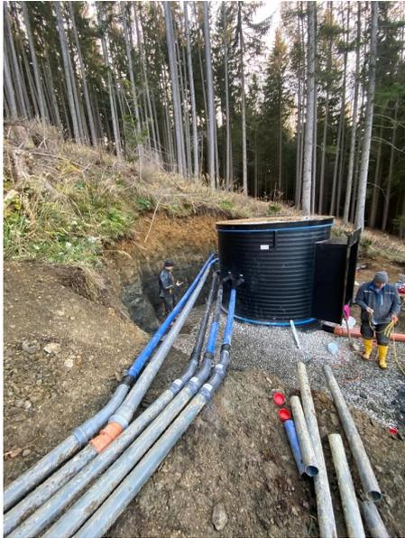
wurde nun eingebaut und in Betrieb genommen. Dieser Sammelschacht ist begehbar und es kann jede einzelne Quelle weg- oder zugeschaltet werden. Außerdem kann auch die Schüttmenge jeder einzelnen Quelle jederzeit abgelesen werden. Dies entspricht dem neuesten Stand der Technik.
